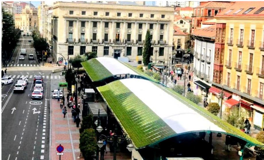
Cubierta vegetal en la Plaza de España de Valladolid
